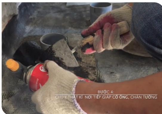
Xử lý cổ ống thoát nước
