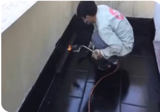
Xử lý góc chân tường
