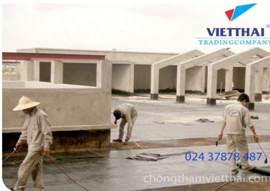
Thi công màng khô nóng
