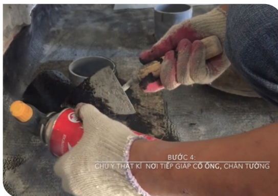
Xử lý cổ ống thoát nước
