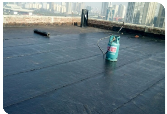
Bề mặt hoàn thiện
