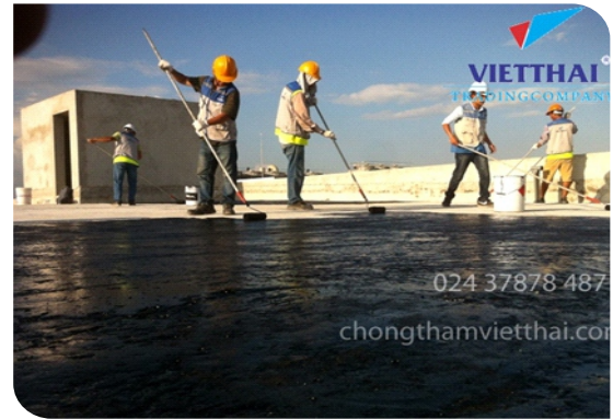
Thi công lăn lớp lót
