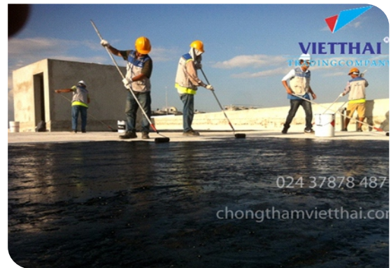
Thi công lăn lớp lót
