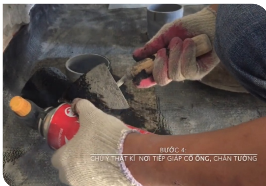
Xử lý cổ ống thoát nước
