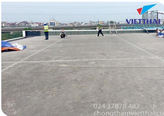
Chuẩn bị bề mặt
