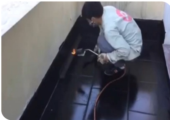
Xử lý góc chân tường
