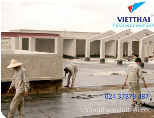
Thi công màng khò nóng
