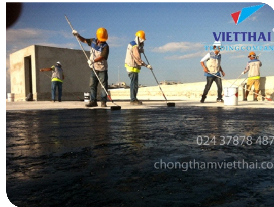
Thi công lăn lớp lót
