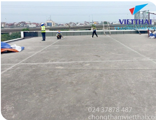
Chuẩn bị bề mặt
