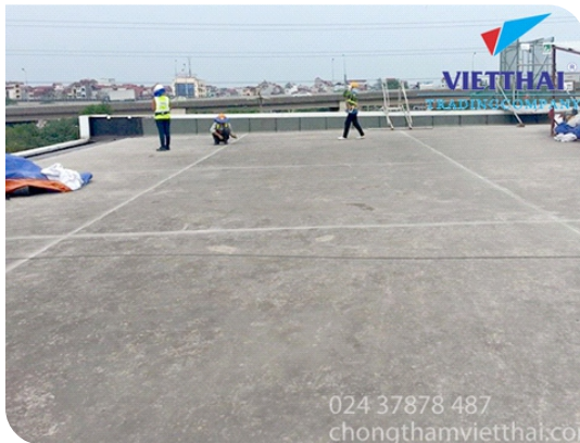
Chuẩn bị bề mặt
