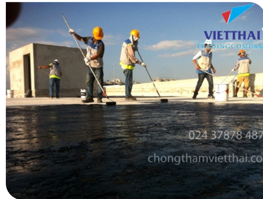
Thi công lăn lớp lót
