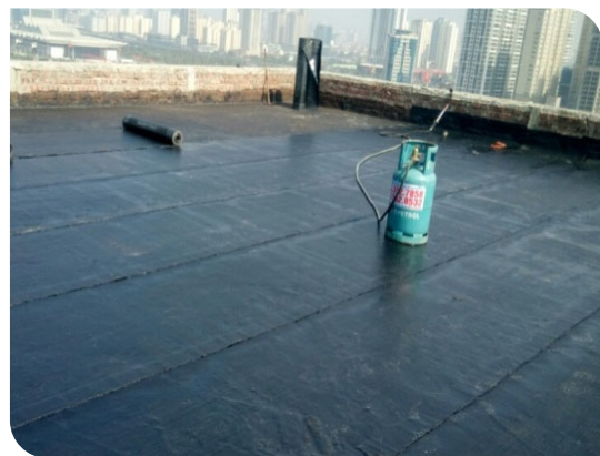
Bề mặt hoàn thiện
