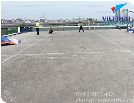
Chuẩn bị bề mặt
