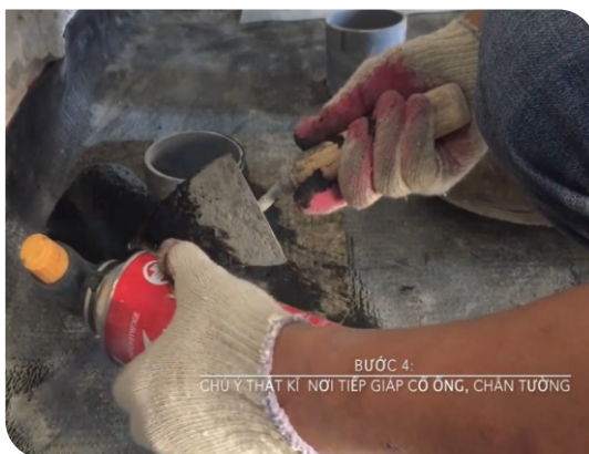
Xử lý cổ ống thoát nước
