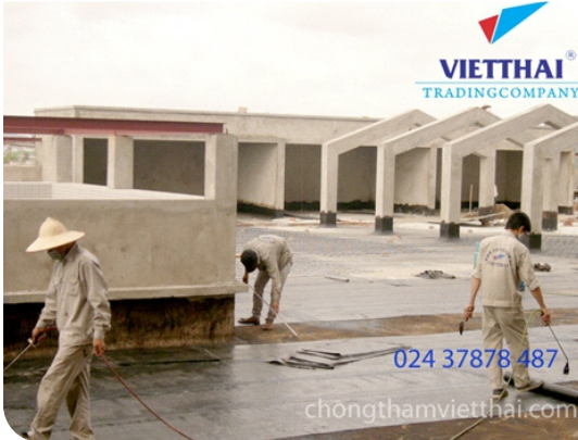
Thi công màng khô nóng
