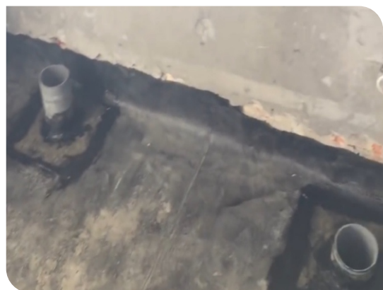
Hoàn thiện cổ ống và góc chân tường
