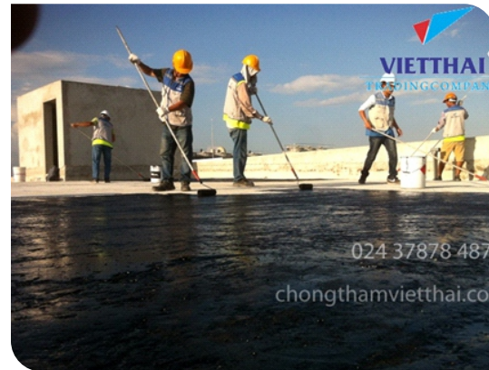
Thi công lăn lớp lót
