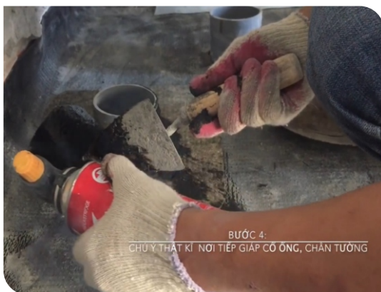
Xử lý cổ ống thoát nước
