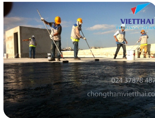
Thi công lăn lớp lót
