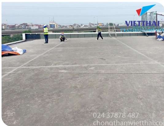
Chuẩn bị bề mặt
