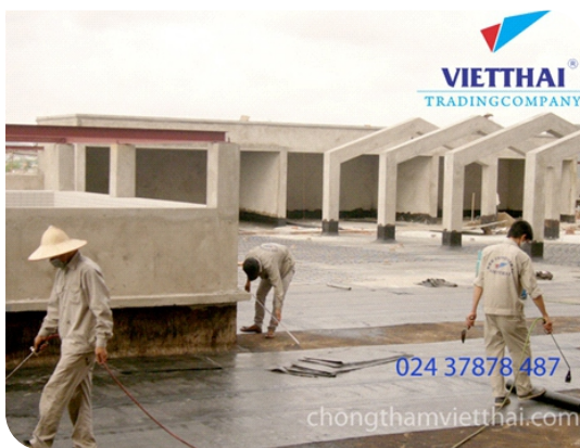
Thi công màng khô nóng
