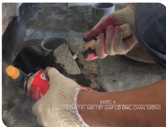
Xử lý cổ ống thoát nước
