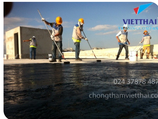
Thi công lăn lớp lót
