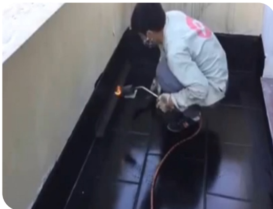
Xử lý góc chân tường
