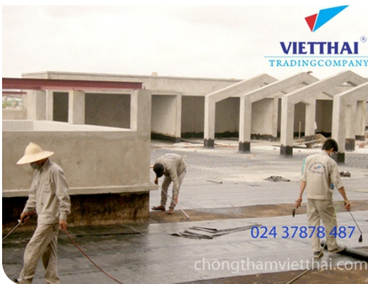
Thi công màng khô nóng
