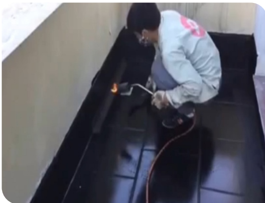
Xử lý góc chân tường
