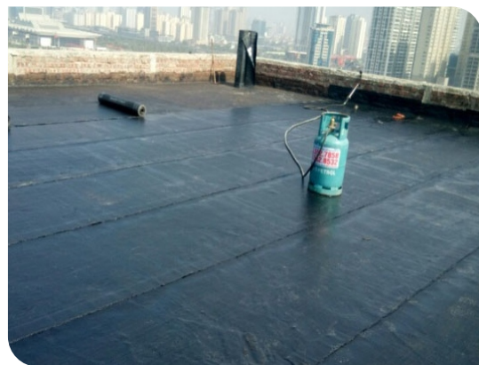
Bề mặt hoàn thiện
