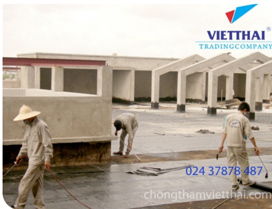
Thi công màng khô nóng
