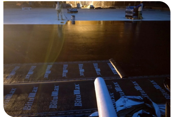
Thi công lăn lớp lót
