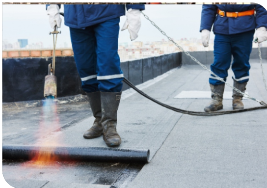
Thi công màng khô nóng
