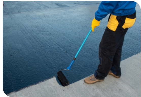
Thi công lăn lớp lót
