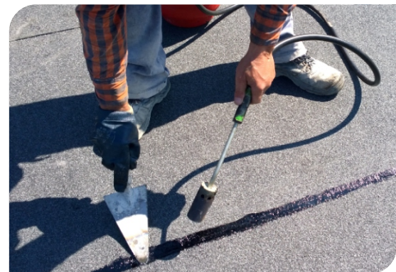
Gia cố các vị trí mép tấm
