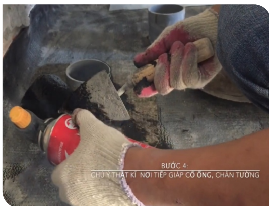
Xử lý cổ ống thoát nước
