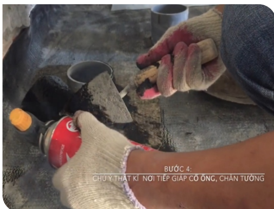
Xử lý cổ ống thoát nước
