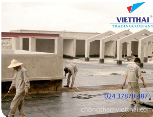
Thi công màng khô nóng
