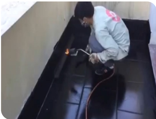
Xử lý góc chân tường
