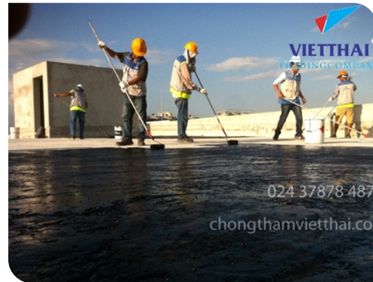
Thi công lăn lớp lót
