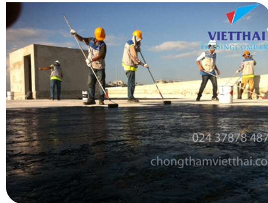
Thi công lăn lớp lót
