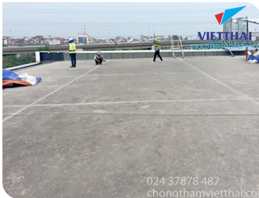
Chuẩn bị bề mặt
