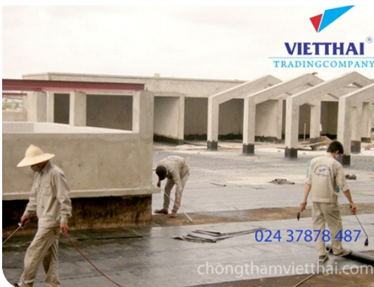
Thi công màng khô nóng
