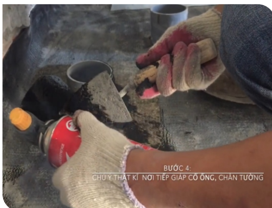
Xử lý cổ ống thoát nước
