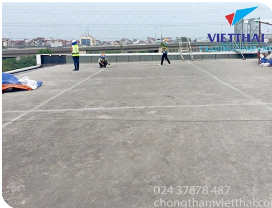
Chuẩn bị bề mặt
