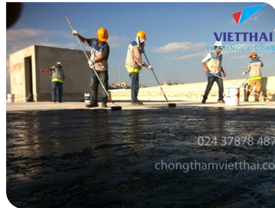
Thi công lăn lớp lót
