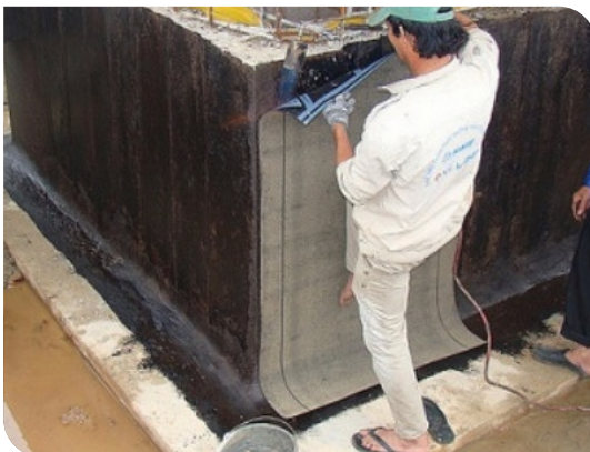
Thi công màng khô nóng
