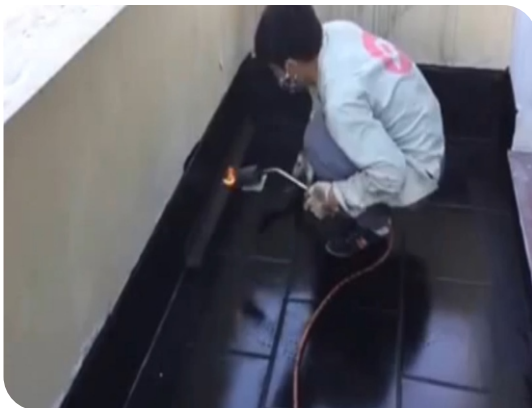
Xử lý góc chân tường
