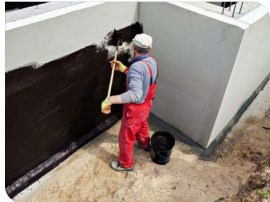
Thi công lăn lớp lót
