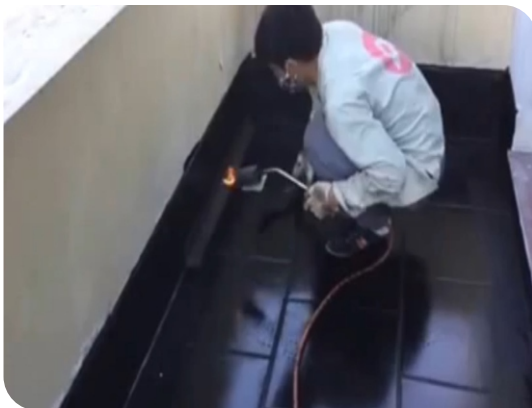
Xử lý góc chân tường
