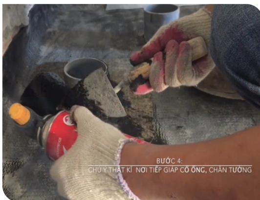
Xử lý cổ ống thoát nước
