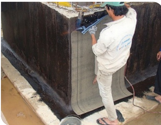
Thi công màng khô nóng
