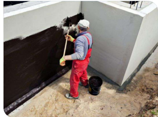
Thi công lăn lớp lót
