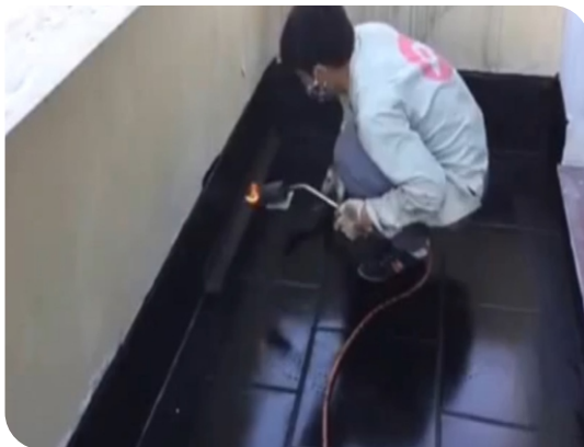
Xử lý góc chân tường
