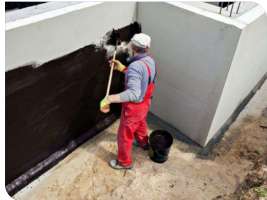
Thi công lăn lớp lót
