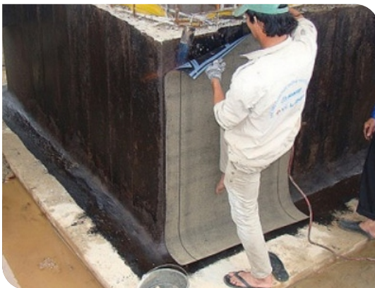
Thi công màng khô nóng
