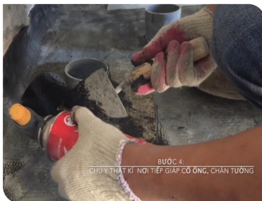
Xử lý cổ ống thoát nước
