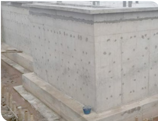
Chuẩn bị bề mặt
