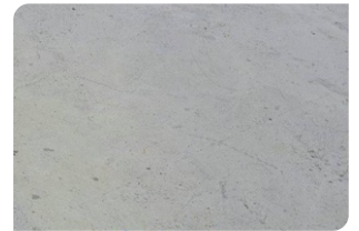
Bề mặt bê tông đạt
