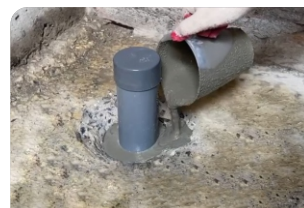
Thi công đổ vữa Lemax Grout LM-G650
