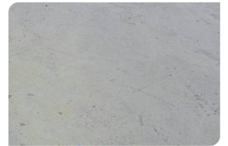
Bề mặt bê tông đạt
