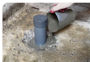
Thi công đổ vữa Lemax Grout LM-G650
