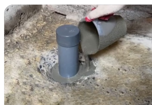
Thi công đổ vữa Lemax Grout LM-G650
