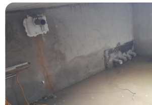
Thi công ghép cấp pha và đổ vữa Lemax Grout LM-G650
