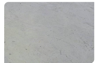
Bề mặt bê tông đạt
