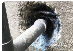
- Vệ sinh, quăn thanh tương nở - Quét chất kết nối Revinox (pha với nước theo tỉ lệ 1:4)
