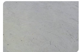
Bề mặt bê tông đạt
