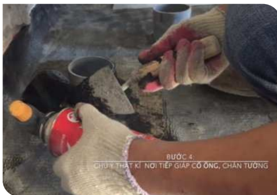
Xử lý cổ ống thoát nước
