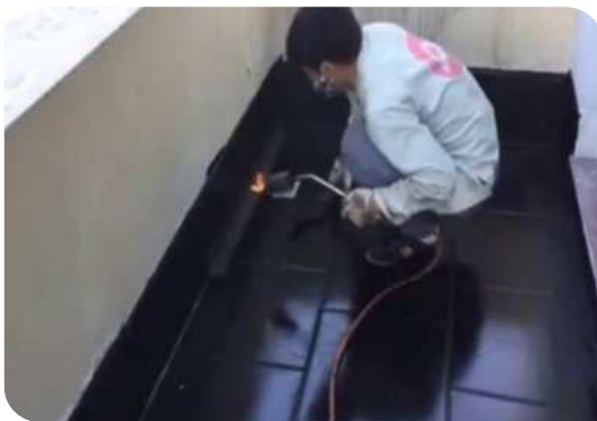
Xử lý góc chân tường
