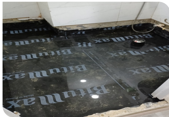
Thi công màng tự dính
