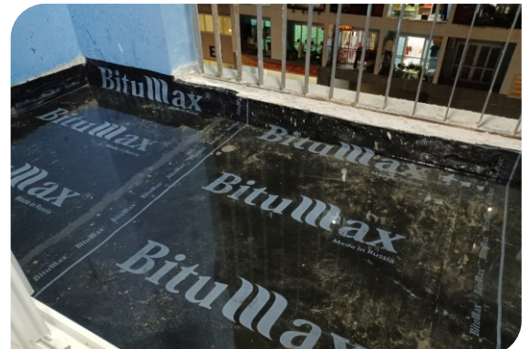
Bề mặt hoàn thiện
