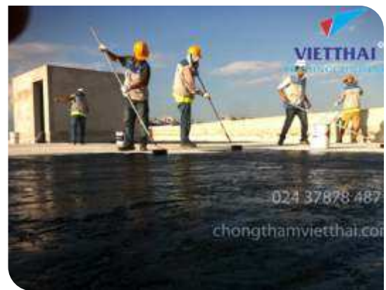
Thi công lăn lớp lót
