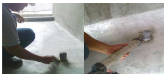
Thi công xử lý cổ ống xuyên sàn
