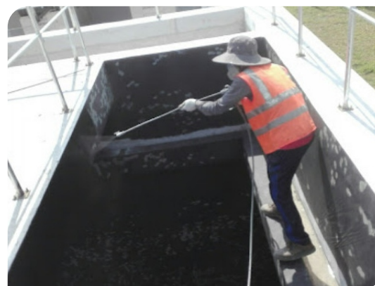
Thi công lớp 2
