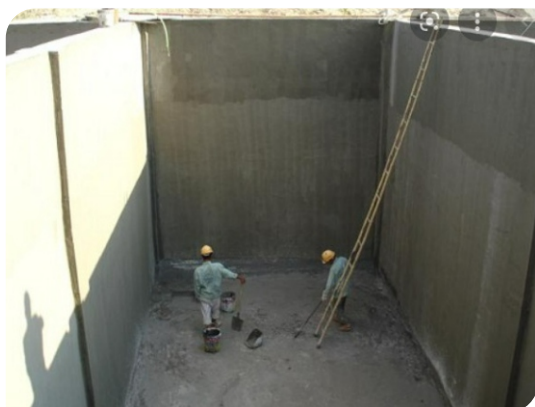
Vệ sinh chuẩn bị bề mặt
