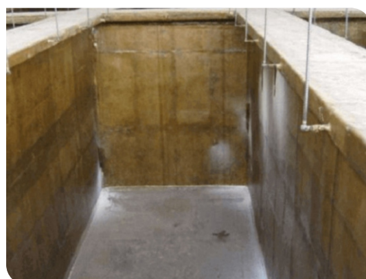
Thi công lớp lót
