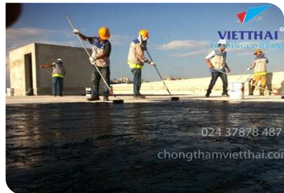
Thi công lăn lớp lót
