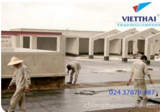
Thi công màng khô nóng
