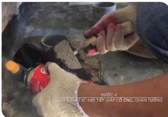
Xử lý cổ ống thoát nước
