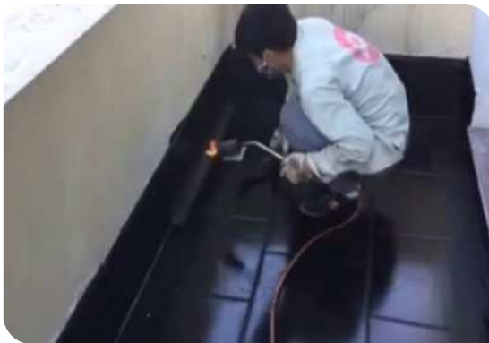
Xử lý góc chân tường
