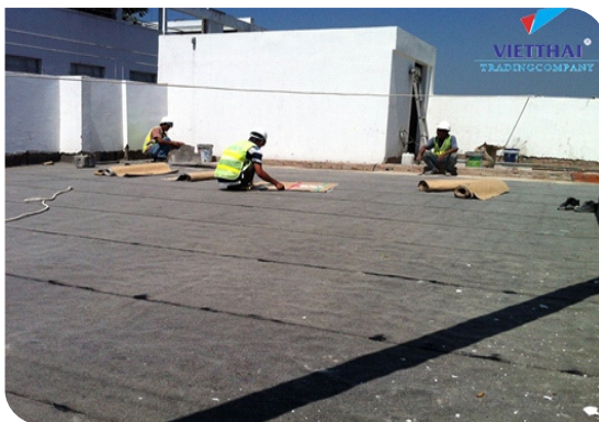
Thi công màng tự dính
