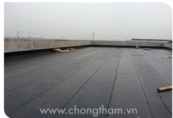
Bề mặt hoàn thiện
