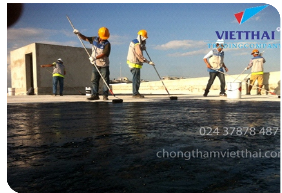
Thi công lăn lớp lót
