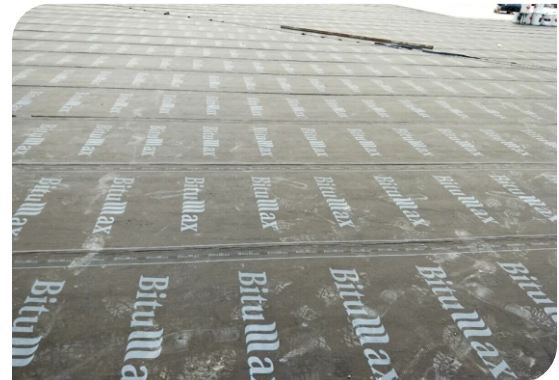
Bề mặt hoàn thiện
