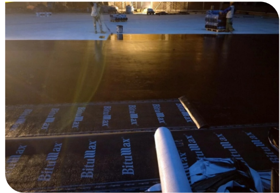
Thi công lăn lớp lót
