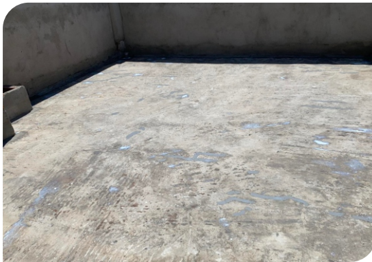
Chuẩn bị bề mặt
