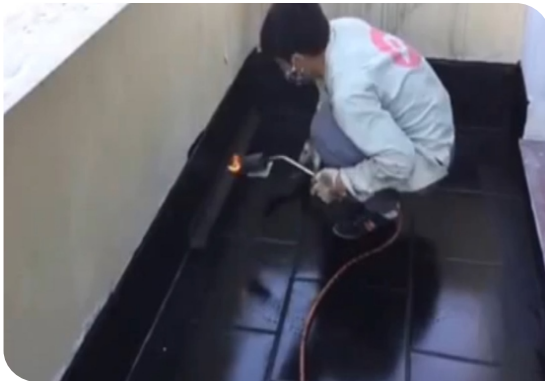
Xử lý góc chân tường
