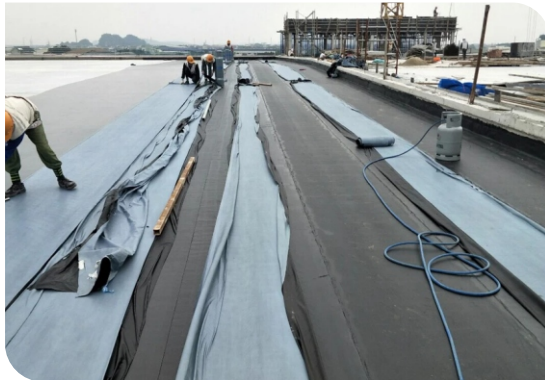
Thi công màng khô nóng
