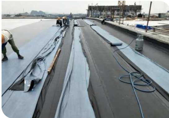
Thi công màng khô nóng
