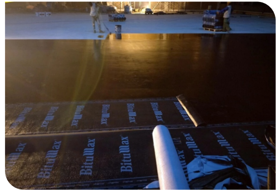
Thi công lăn lớp lót
