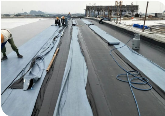
Thi công màng khò nóng
