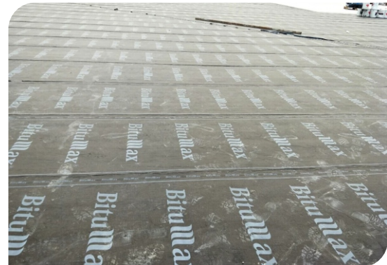
Bề mặt hoàn thiện
