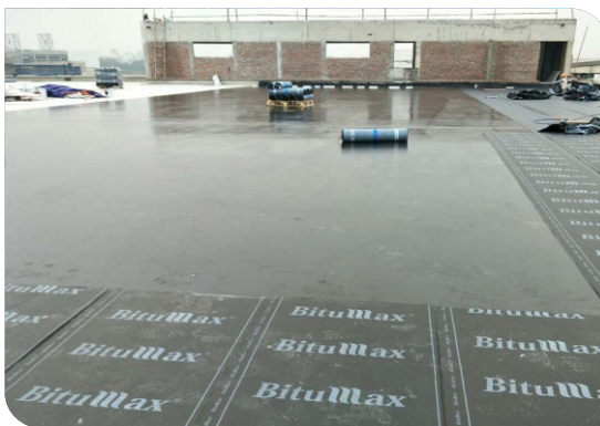
Thi công màng tự dính
