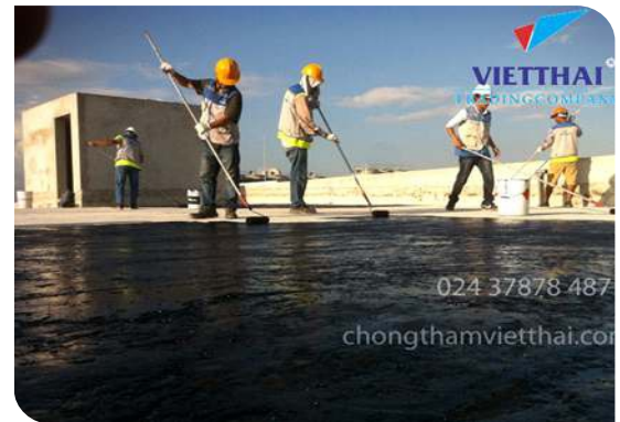
Thi công lăn lớp lót
