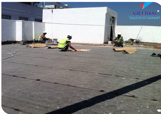
Thi công màng tự dính
