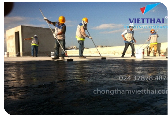
Thi công lăn lớp lót
