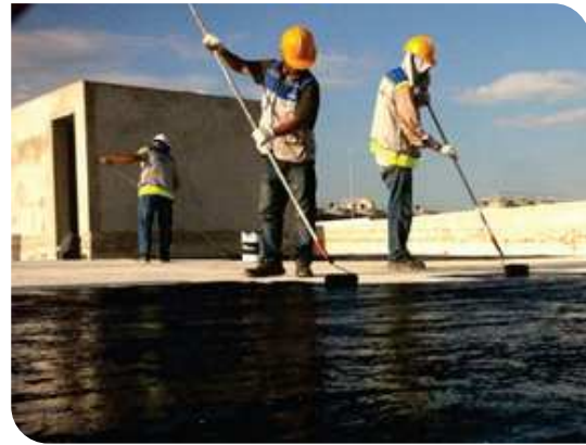
Thi công lăn lớp lót
