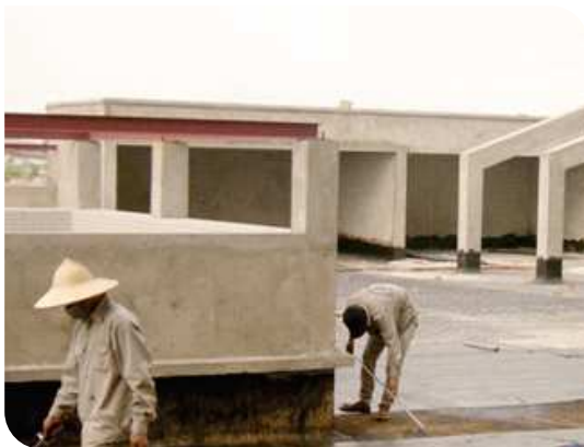
Thi công màng khô nóng
