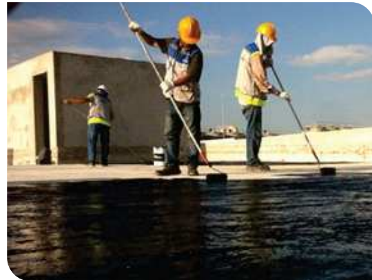
Thi công lăn lớp lót
