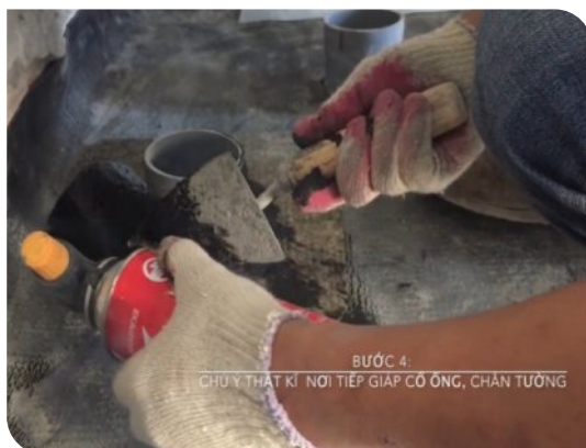
Xử lý cổ ống thoát nước
