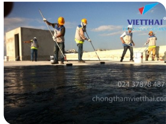
Thi công lăn lớp lót
