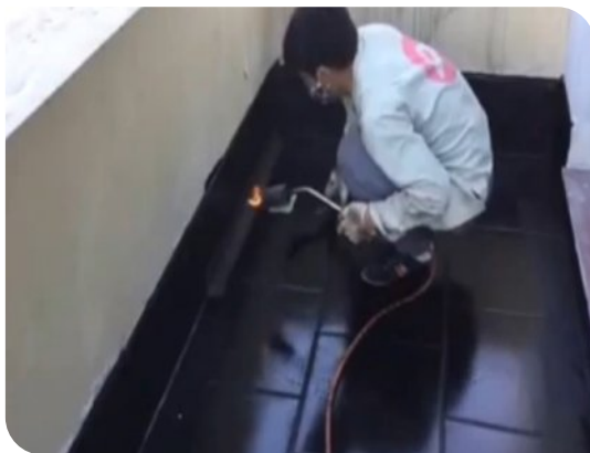
Xử lý góc chân tường
