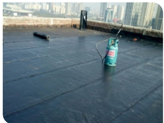
Bề mặt hoàn thiện
