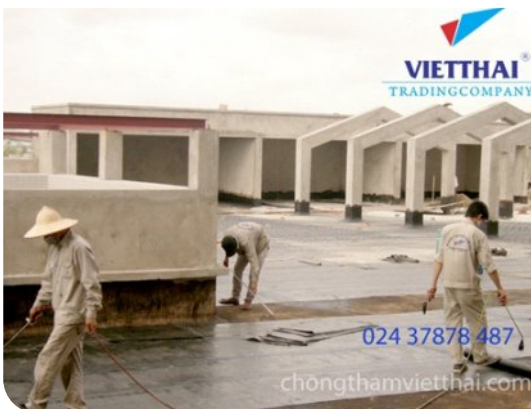
Thi công màng khô nóng
