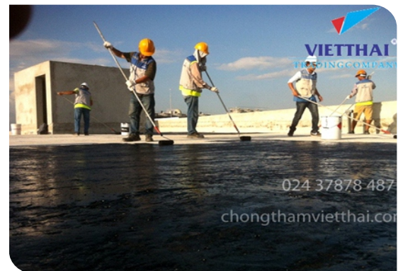
Thi công lăn lớp lót
