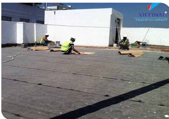
Thi công màng tự dính
