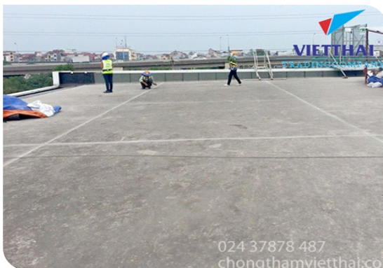
Chuẩn bị bề mặt
