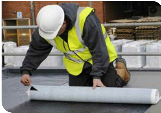
Thi công màng tự dính
