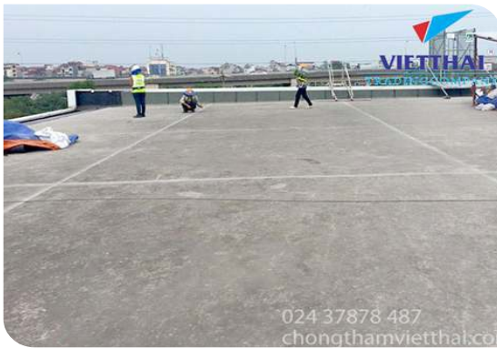
Chuẩn bị bề mặt
