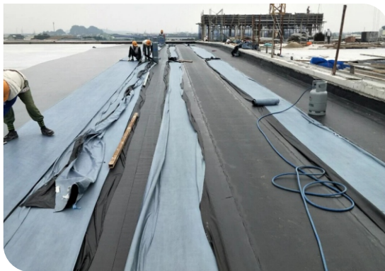
Thi công màng khò nóng
