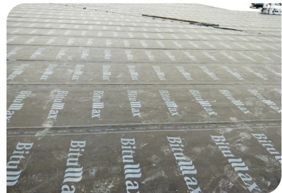
Bề mặt hoàn thiện
