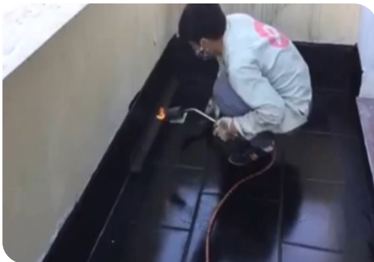
Xử lý góc chân tường
