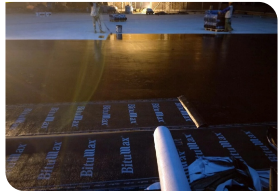
Thi công lăn lớp lót
