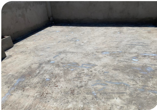
Chuẩn bị bề mặt
