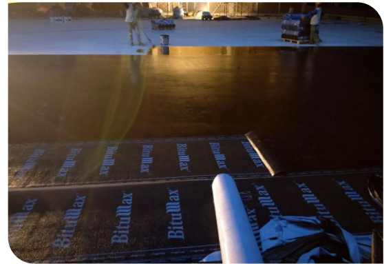
Thi công lăn lớp lót
