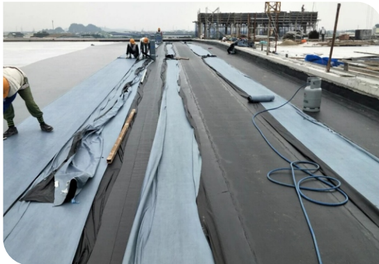
Thi công màng khô nóng
