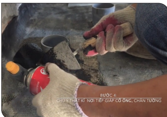
Xử lý cổ ống thoát nước
